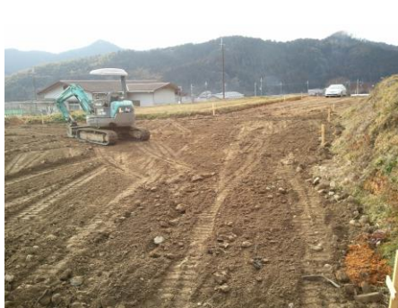
写真中：造成工事
