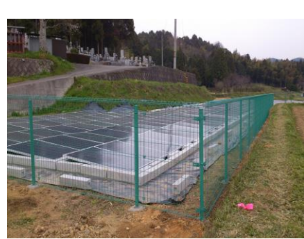
写真右：完成写真
