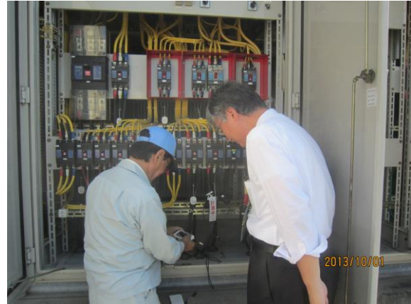
写真右：計測装置取り付け
