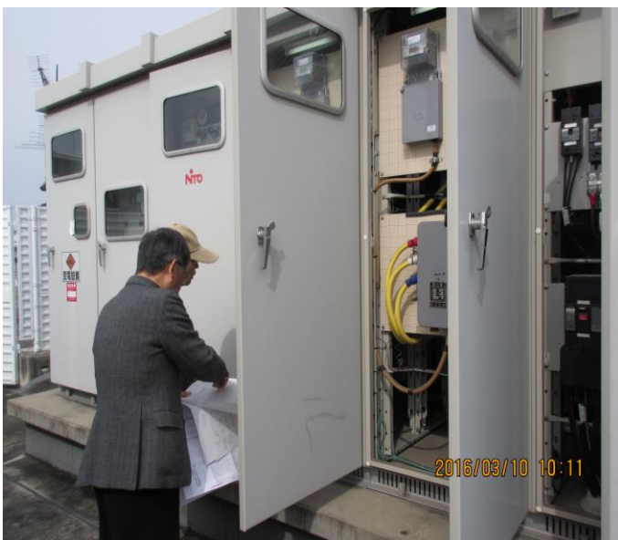
キュービクルでの取付場所確認作業
