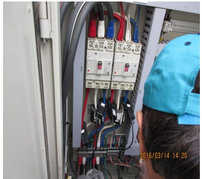
分電盤への計測装置設置
