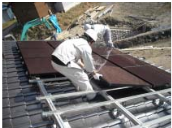
支持瓦と取り付け枠
