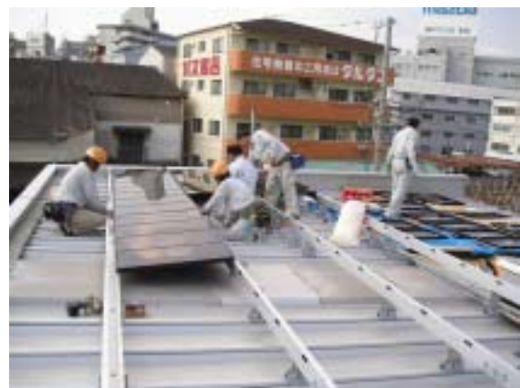
太陽光発電モジュールの取付け 架台と設置作業
