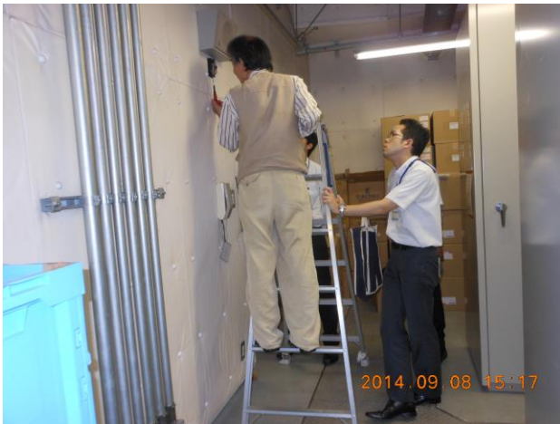
写真左：診断調査の様子
